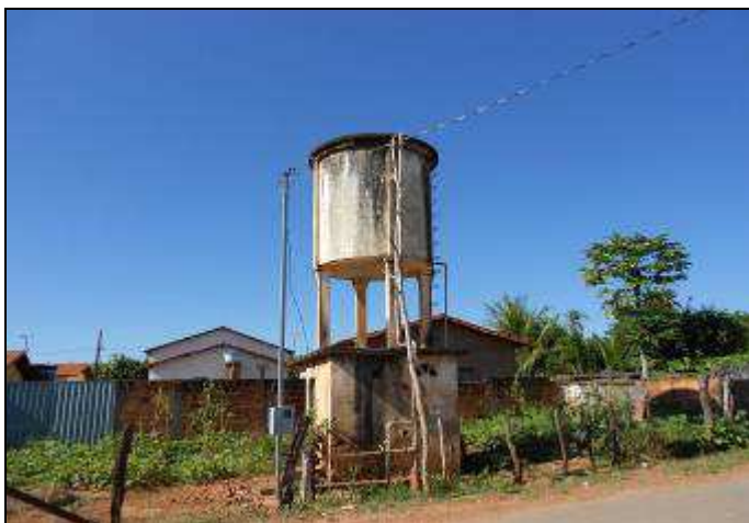
Foto 07 – Reservatório 01 existente a ser desativado.
