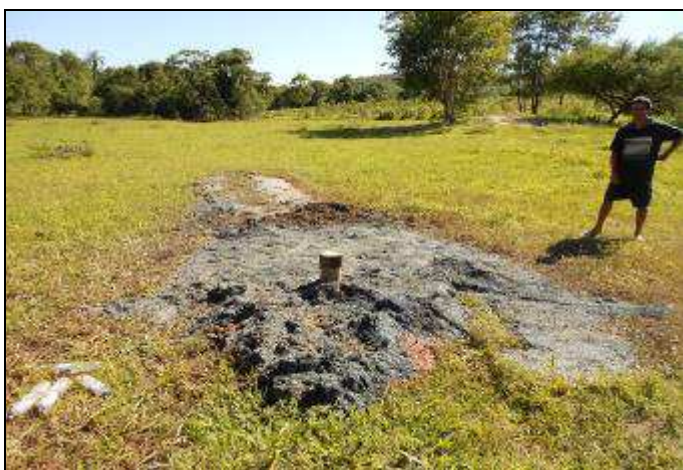
Foto 06 – Poço E-02. Essa unidade será utilizado para o abastecimento de água projetado.
