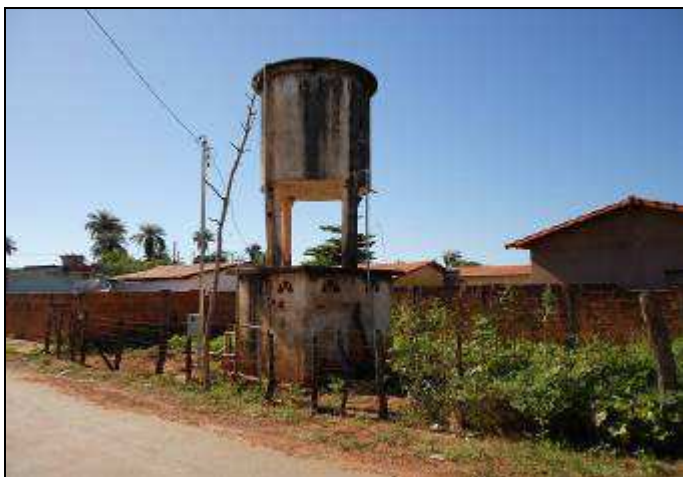
Foto 04 – Área do poço E-01 existente.
