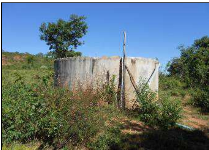
Foto 08– Reservatório existente 02 a ser desativado. Estrutura sem laje superior.
