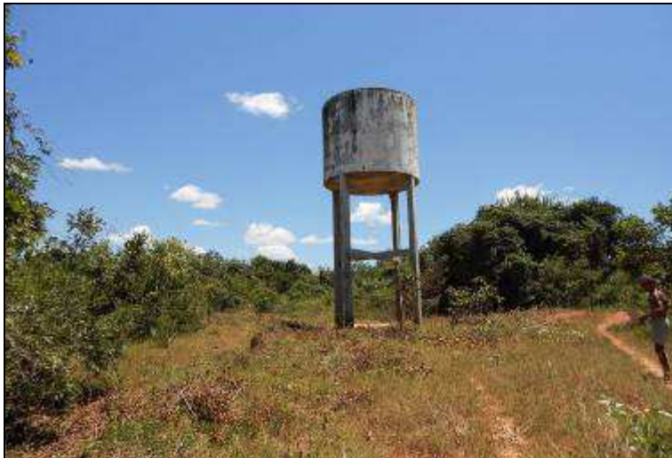
Foto 9 – Próximo a área do R1, será implantado o reservatório projetado.
