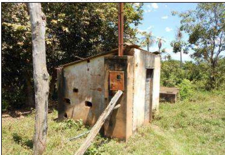
Foto 04 – Área do poço – sistema de captação
