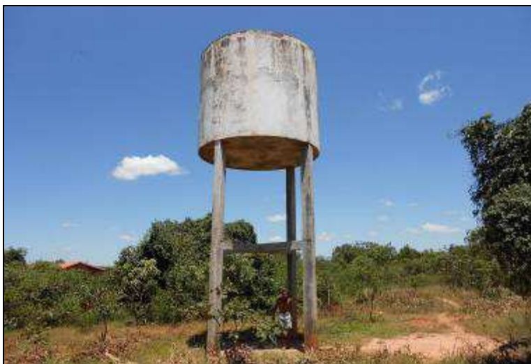
Foto 06 – Vista do reservatório 01 a ser desativado
