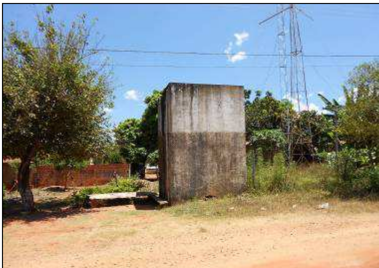
Foto 07– Reservatório 02 a ser desativado
