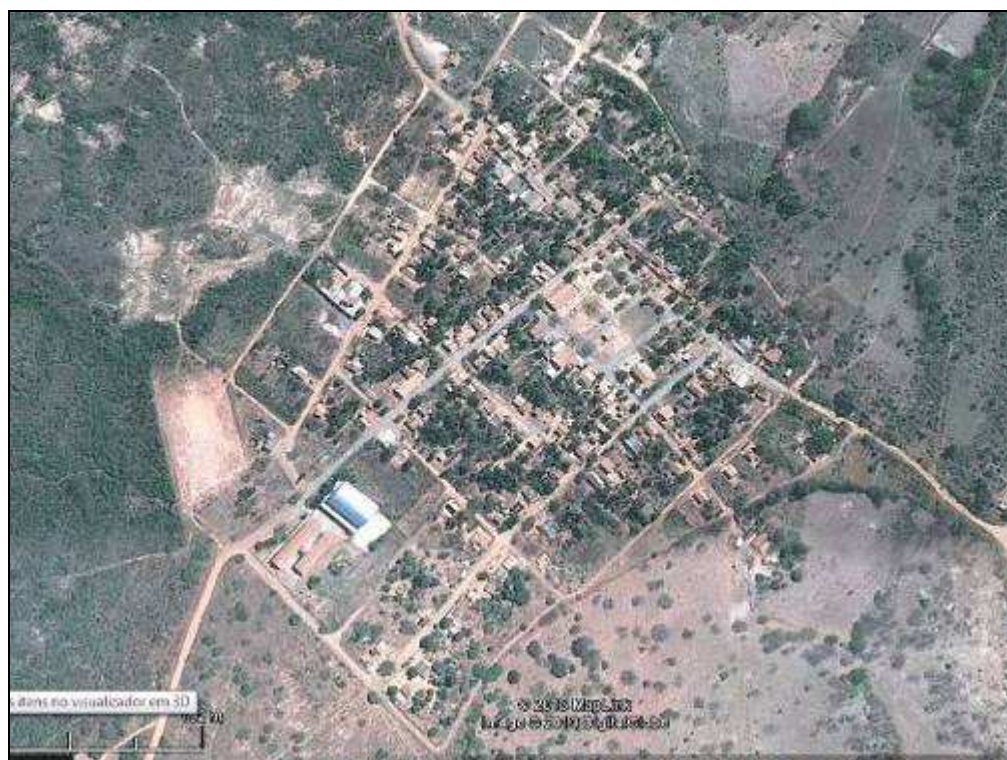
Figura 03 - Imagem da sede do Distrito Brejinho
