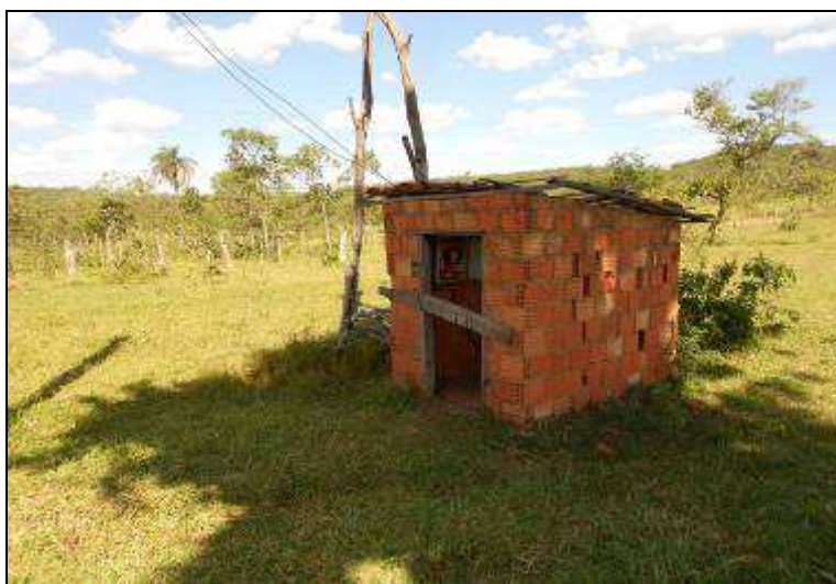
Foto 04 – Área do poço existente
