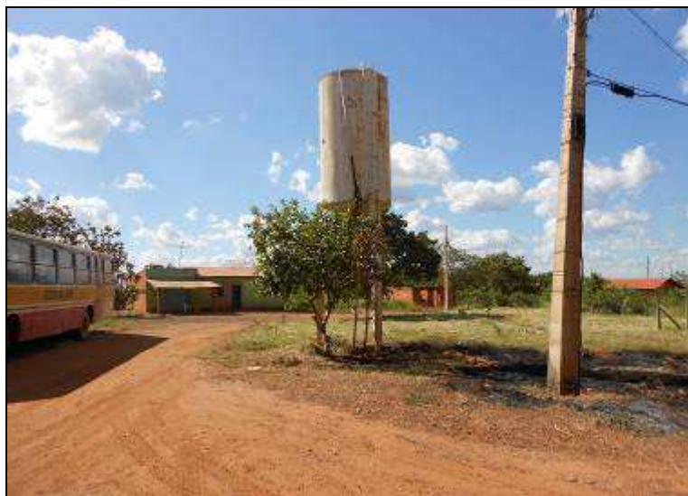
Foto 08– Reservatório existente -5m 3 .
